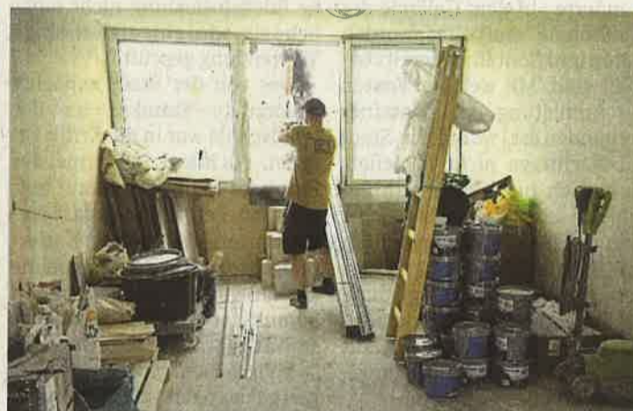
Im Februar sind die Arbeiten gestartet und sollen ein Jahr dauern.
